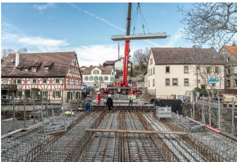
© Tom Bauer, Projekt: Staatsstraße St1003, Gollachbrücke Aub
