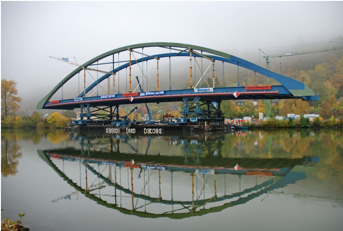
Einschwimmen der Mainbrücke Segnitz
